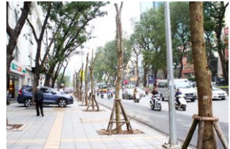
Cây chống không phù hợp với kích thước cây
