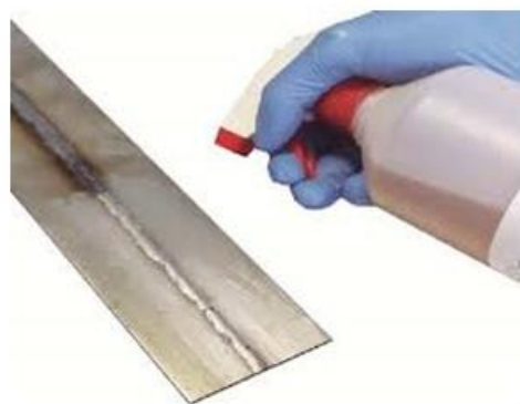
Làm sạch bề mặt kim loại bằng HCl
