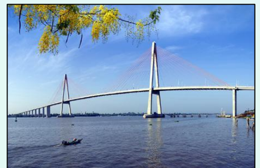
Hình 3: Cầu Rạch Miễu
