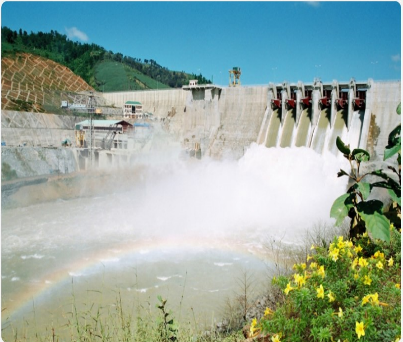
Nhà máy thủy điện Yaly
