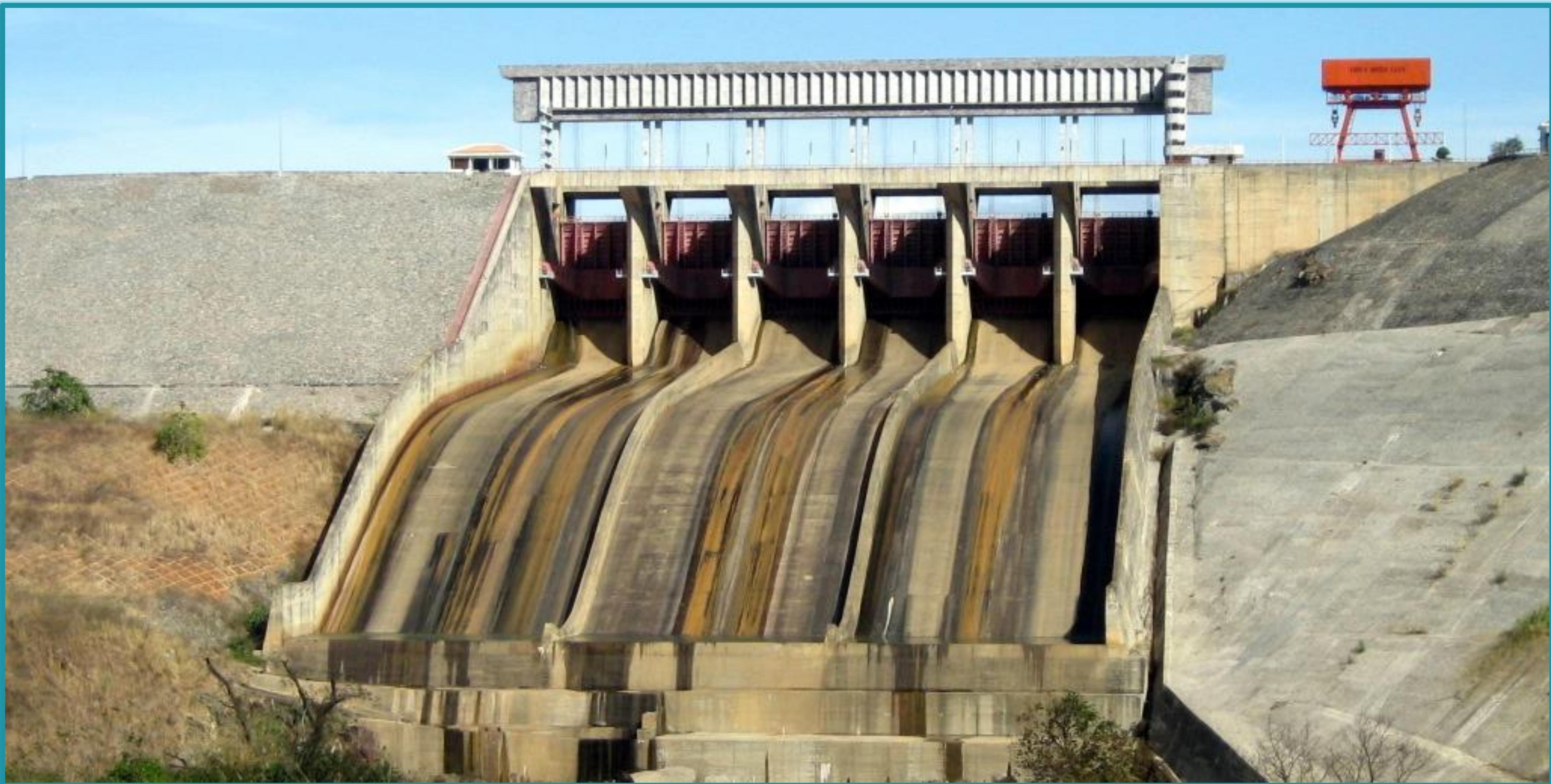
NHÀ MÁY THỦY ĐIỆN YALY
